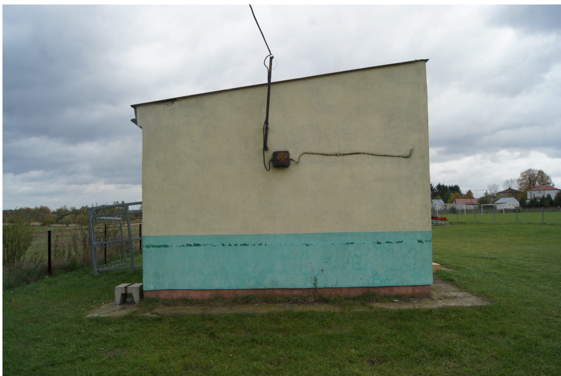
Fot. 4. Elewacja boczna – zachodnia.
