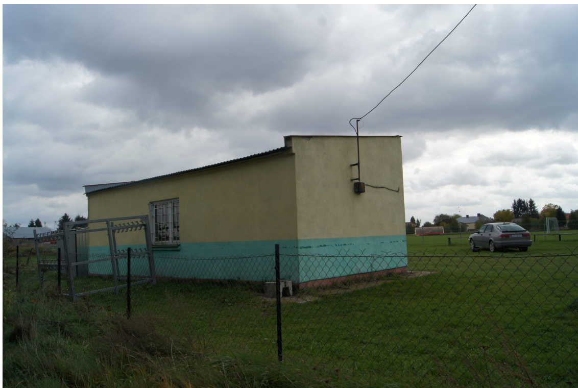
Fot. 3. Elewacja tylna – północna.
