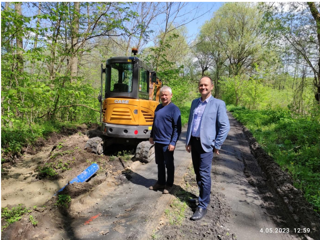
Zdjęcie 3. Budowa infrastruktury wodno-kanalizacyjnej w Gminie Ruda-Huta (w trakcie prac)
