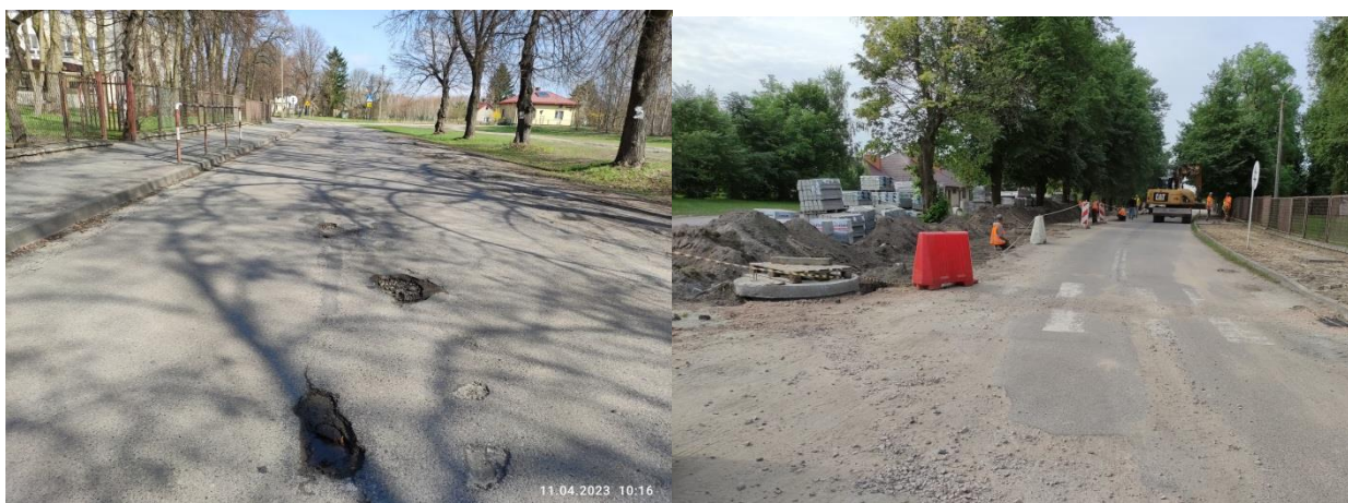
Zdjęcie 11. Droga w Rudzie-Hucie, ul. Wójtowicza (w trakcie realizacji).
