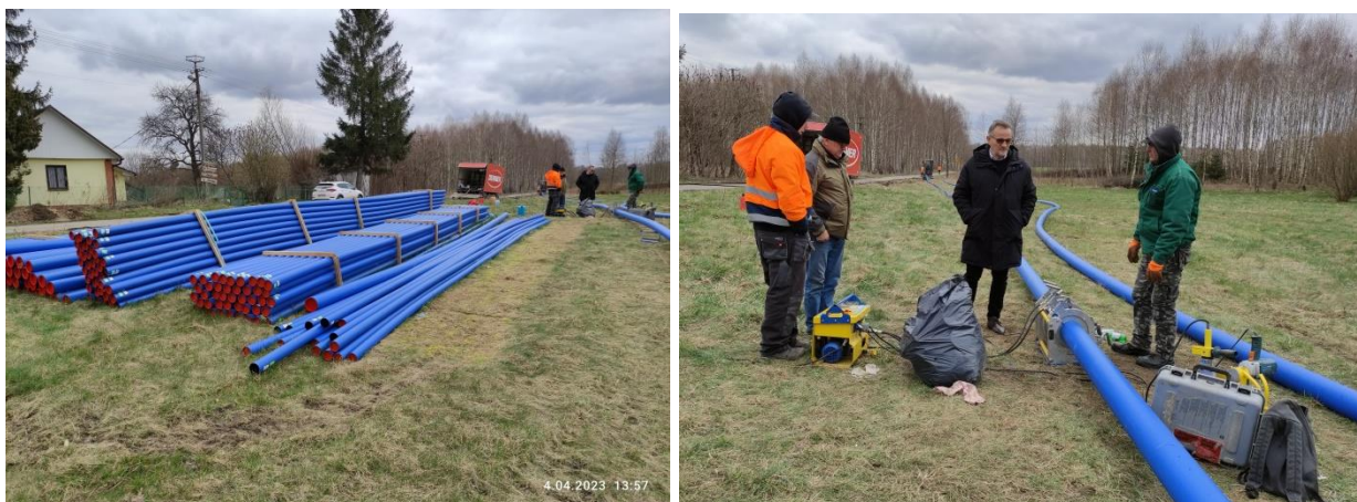
Zdjęcie 2. Budowa infrastruktury wodno-kanalizacyjnej w Gminie Ruda-Huta (w trakcie prac)
